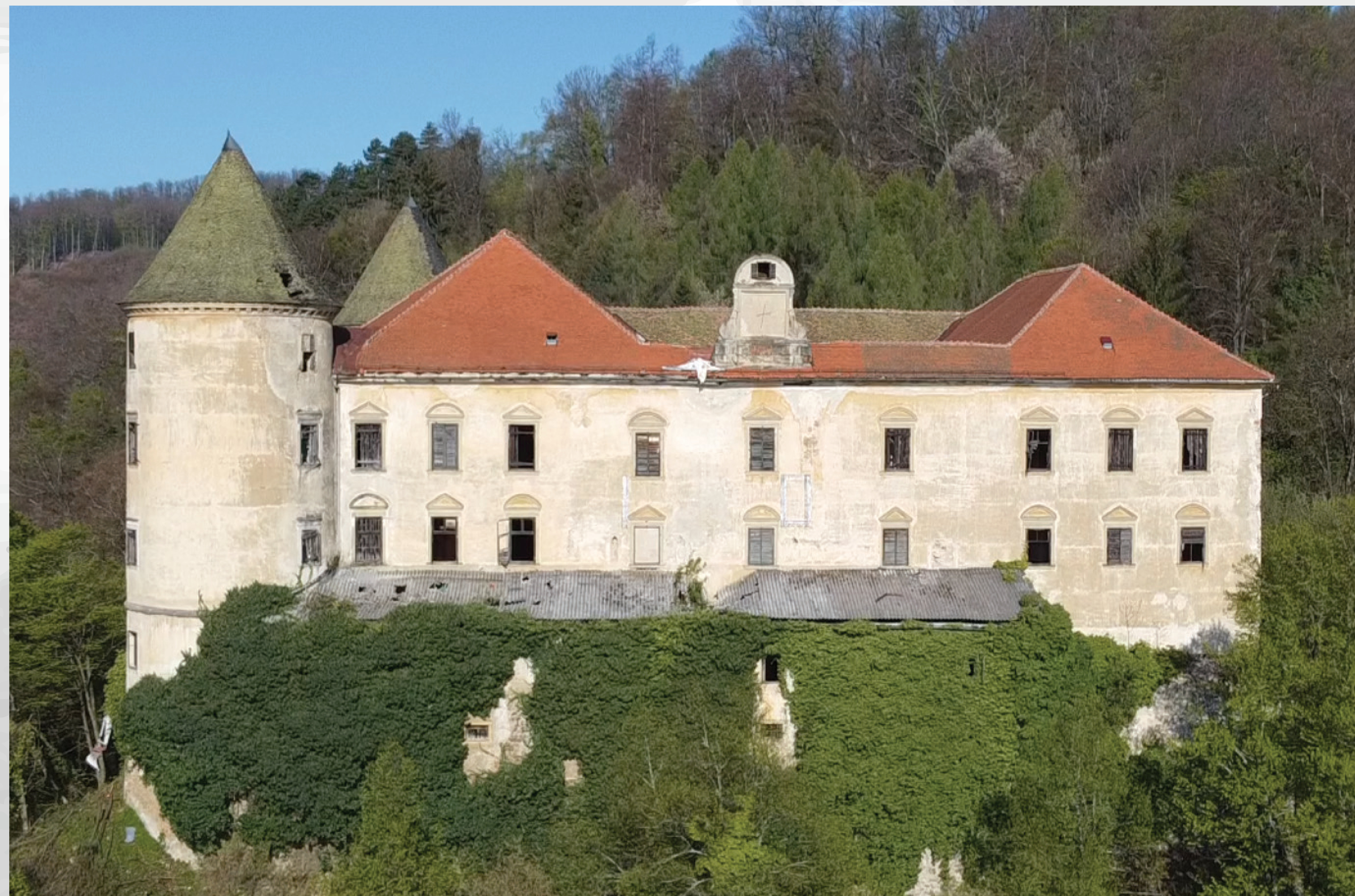
Propadajoči grad Podčetrtek (vir: Željko Krstović, 2019.)
