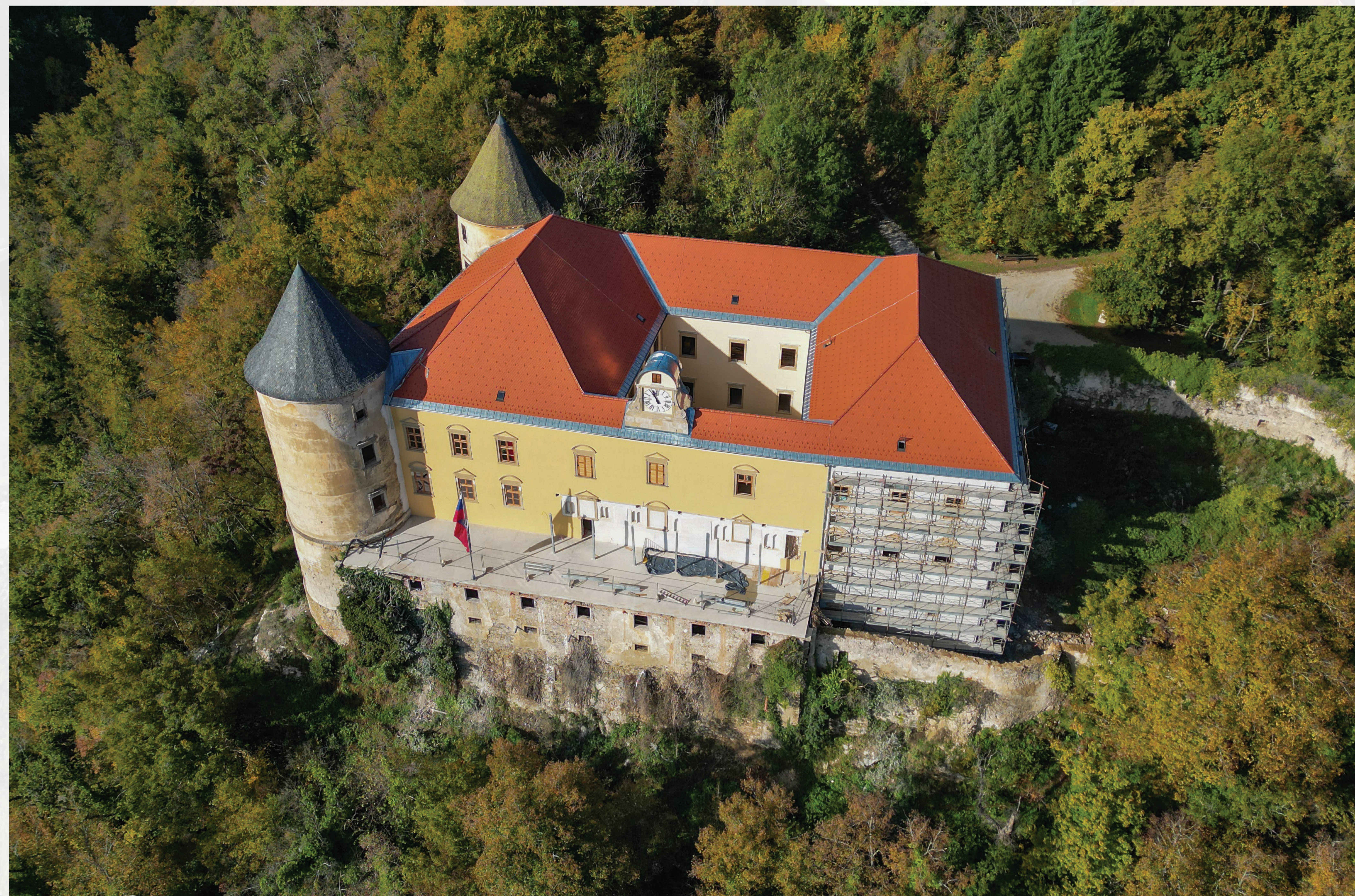
Grad Podčetrtek med obnovo (vir: Goran Rovani, 2023).
